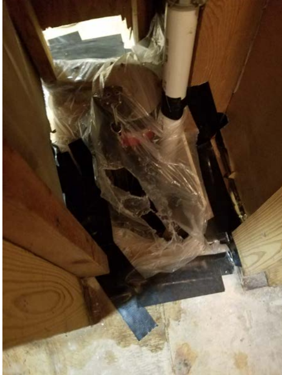
016_Sump_seal_torn_cat_cannot-sample
